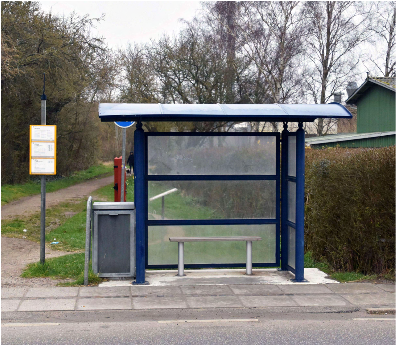
Også i Rødbyhavn er der ligesom i Nakskov en mindre læskærm, dog udstyret med bæk, der virker til at være efterinstalleret.
