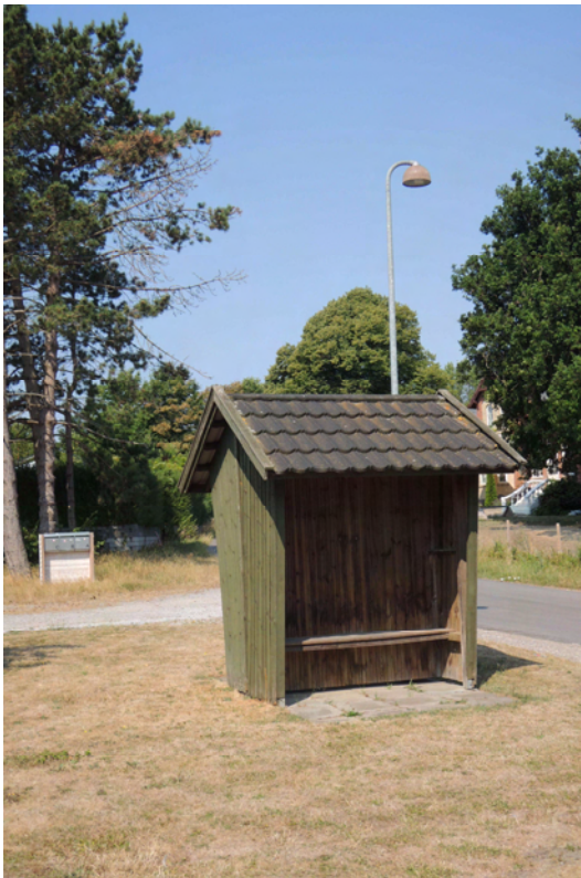
Skolebussen mellem Kalvehave og Nyråd på Sydsjælland betjener dette læskur i Stensby. (Foto Jens Birch)
