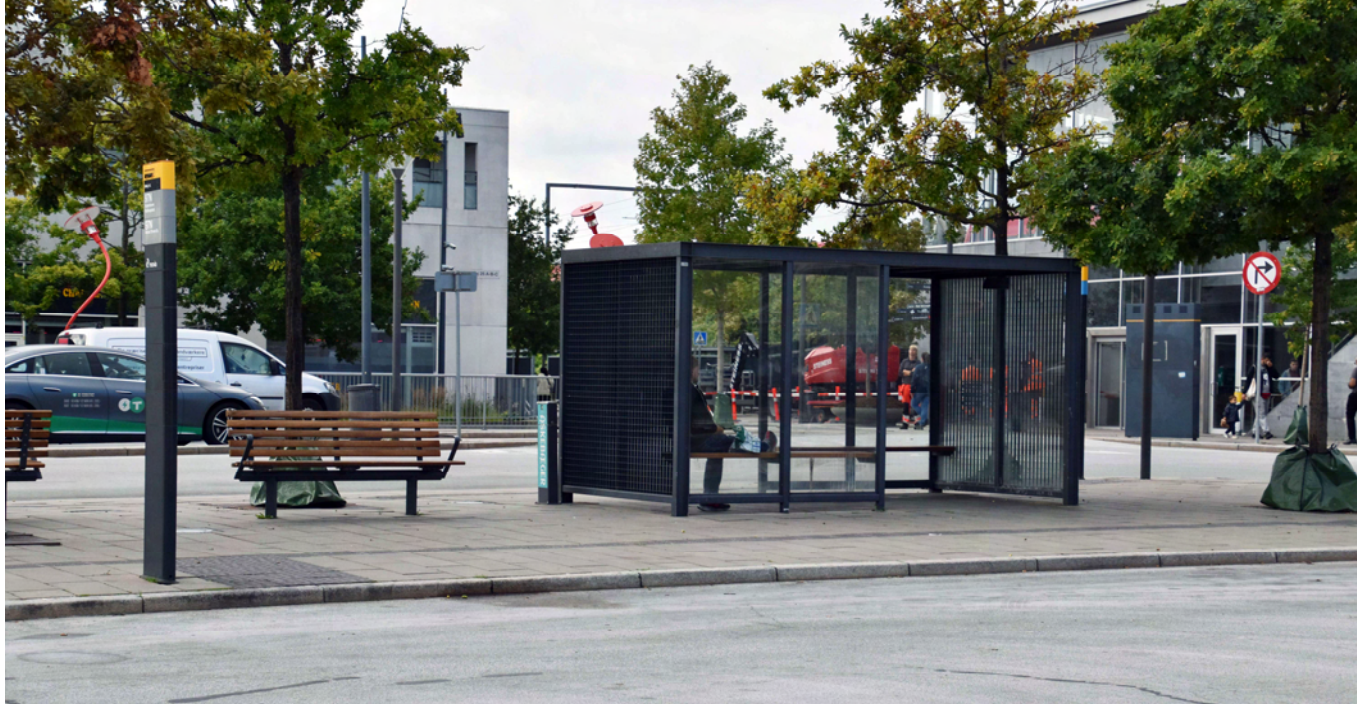
En nyere version af en metallæskærm med gennemgang i Ishøj.
