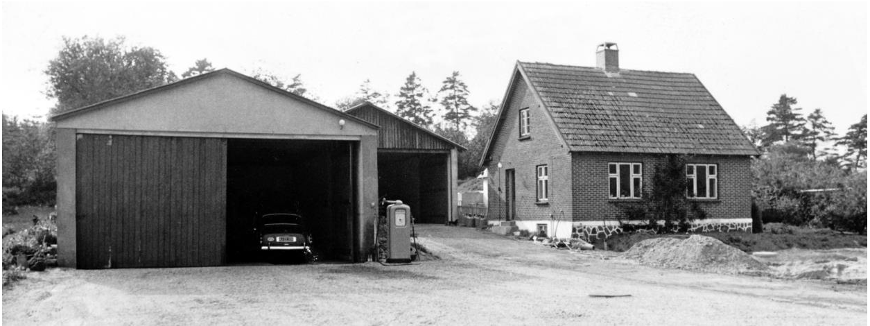
En ny og større busgarage blev bygget i Rostved i 1956. Busserne blev i de gode år i 1950'erne bredere og længere.
