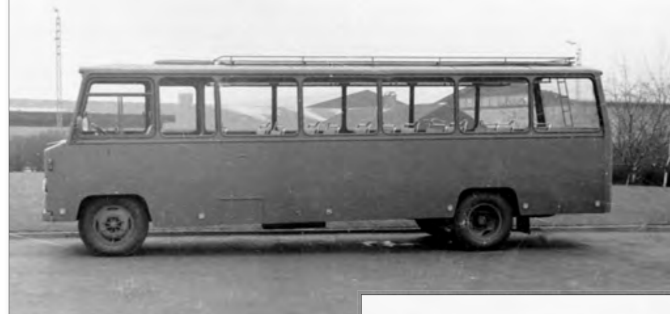
Type SB årgang 1970 med karosseri fra Ringsted Karosserifabrik. Op gennem 1960'erne og indtil 1971 anskaffede det danske forsvar mere end 70 eksemplarer af type SB – nogle med benzinmotor (SB3), andre med dieselmotor (SB5). Karosserierne blev leveret af Ringsted Karosserifabrik, som først med leverancen fra 1970 ændrede karosseridesignet til et mere moderne og samtidigt udseende. (Arkivfoto Jens Birch)
